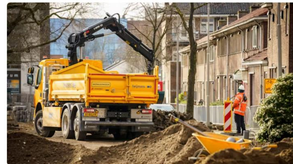
Beeld van de emissievrije werkzaamheden aan het fietspad. (Foto's: gemeente Arnhem)
